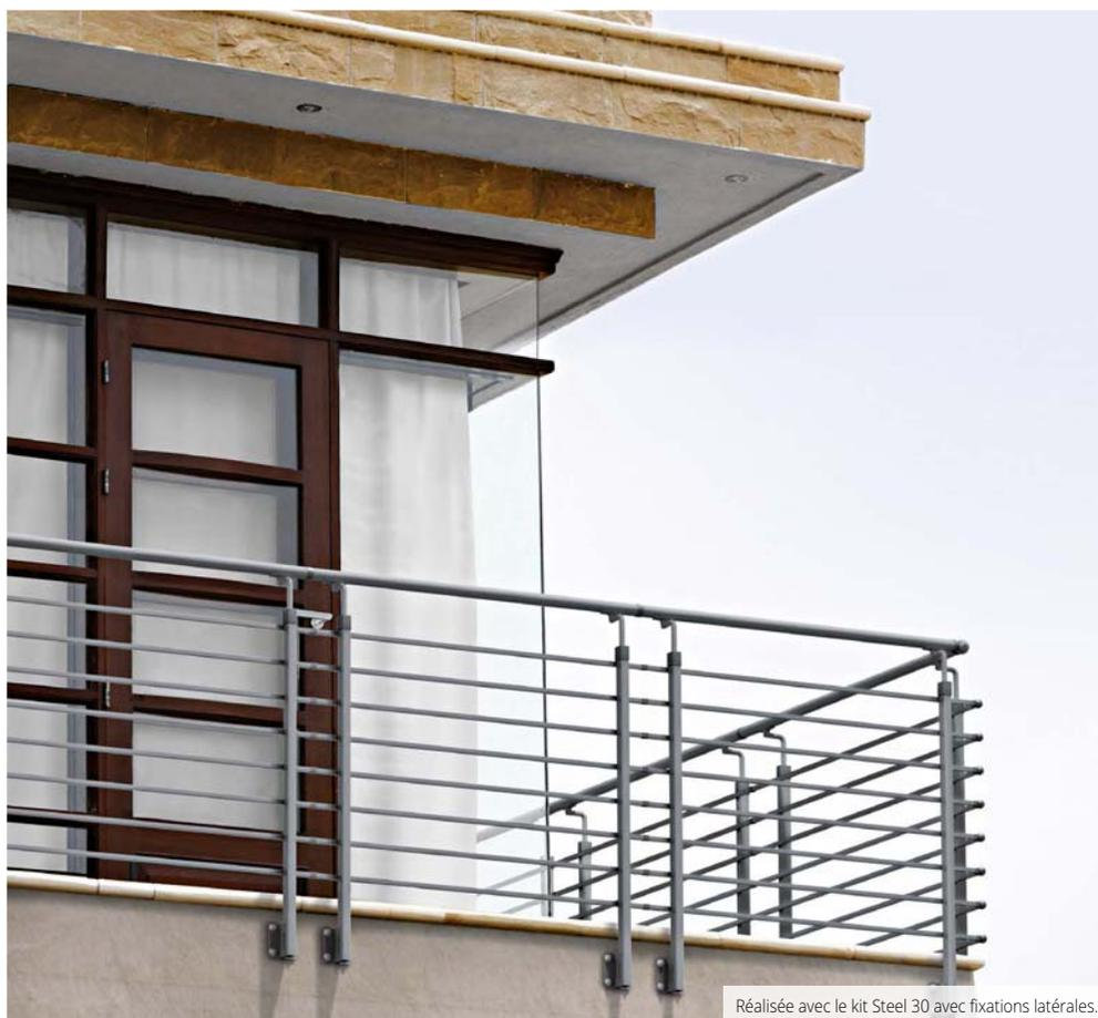
Réalisée avec le kit Steel 30 avec fixations latérales.
